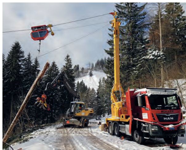
Neuer Mobilseilkran im Einsatz
