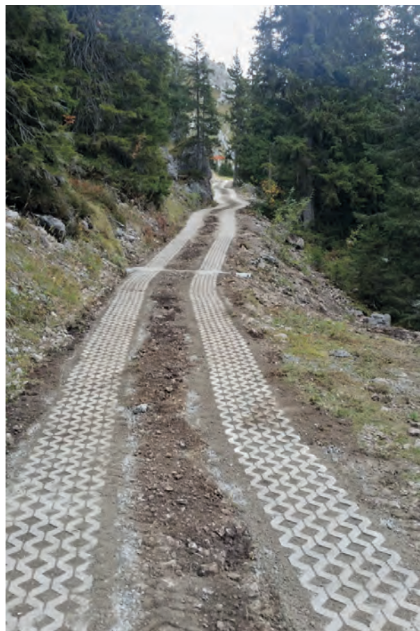
Tumli-Strasse: Einbau Rasenraster
