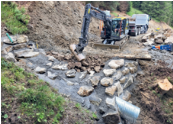
Einbau Durchlass 6. Etappe Forststrasse Ettlismatt – Eggbrunnen
