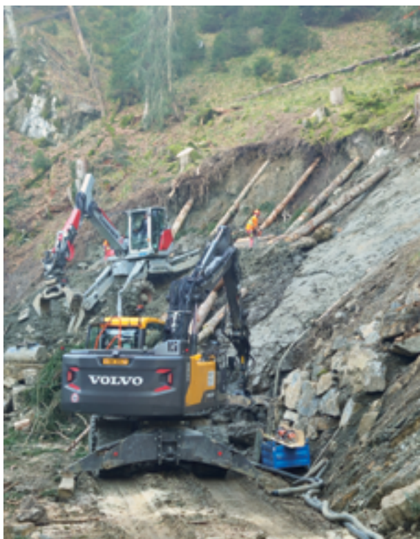
Rutsch Ende Bauzeit 6. Etappe Forststrasse Ettlismatt – Eggbrunnen
