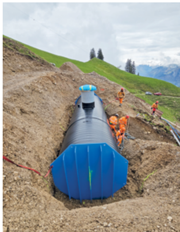
Einbau Wasserreservoir beim Wasserversorgungsprojekt Ämsigen-Chretzen
