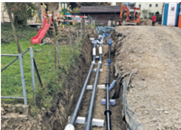
Fernwärmeleitungsbau im Gebiet Laubligenstrasse – Feldheimstrasse
