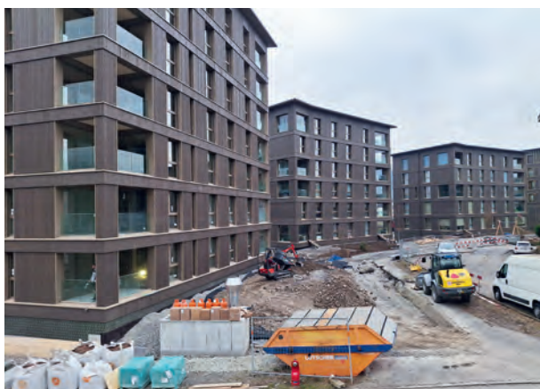
Entwicklung auf Baustelle «Überbauung Allmendweg 6, 8 und 10» (Stand: 17.2.2025)
