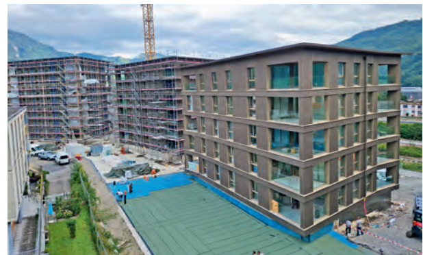
Überbauung Allmendweg 6, 8 und 10 (Stand: 19.08.2024)
