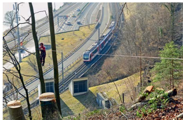
Holzschlag oberhalb Zentralbahn und A8 in Alpnachstad
