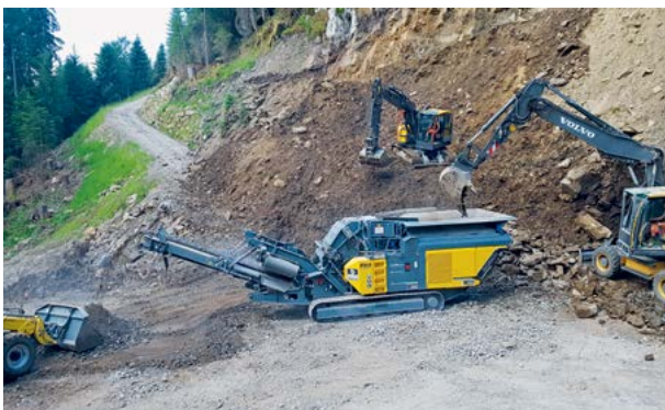
Kofferaufbereitung für Bau Forststrasse Ettlismatt – Eggbrunnen
