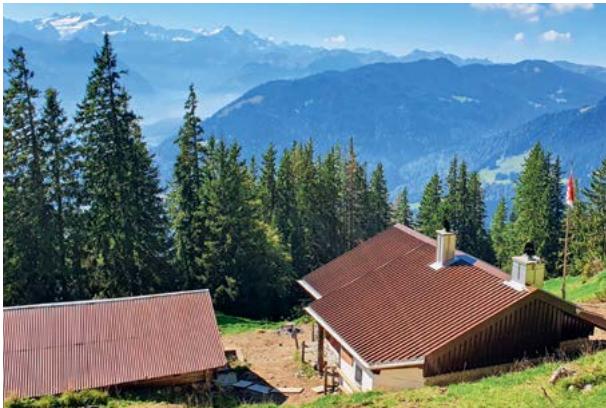
Dachsanierung bei der Alphütte unteres Ruessi
