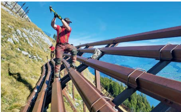
Beseitigung Steinschlag bei Lawinenverbauung Matthorn
