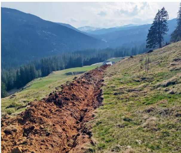
Sanierung Wasserversorgung auf Alp Horweli
