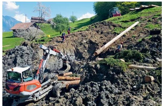
Hangverbau mit Holzkasten in der Hinteregg
