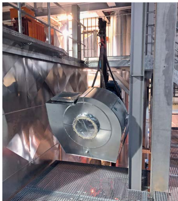
Einbau Abgas-Rezirkulation auf dem Heizkessel 2
