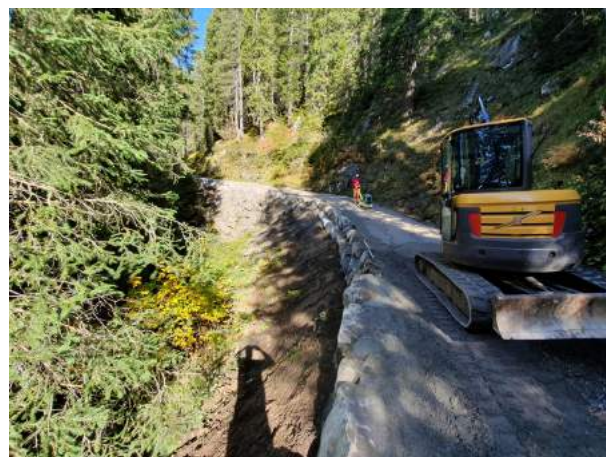
Böschungssicherung auf der Alpstrasse Horweli - Älggäu
