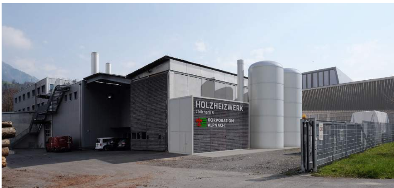
Bestehendes Holzheizwerk mit Schnitzelsilo 1, Speicher und Zweckbau für redundante Wärmeerzeugung
