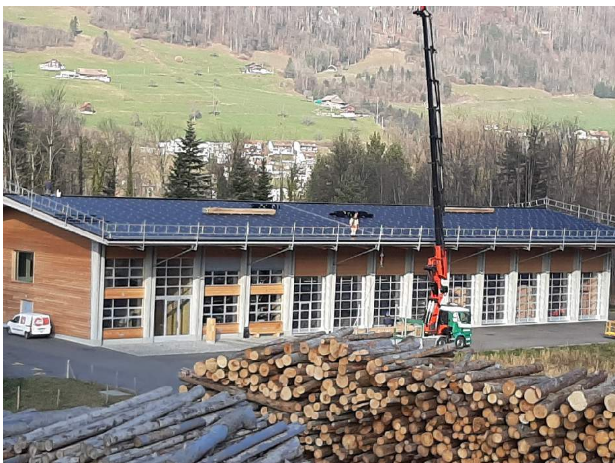
Vorbereitungsarbeiten für die Photovoltaikarbeiten auf dem Forstwerkhof Chilcherli
